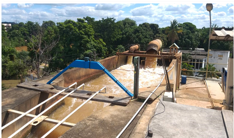
Figura 4: Calha Parshall. Fonte: Os autores (2020).
