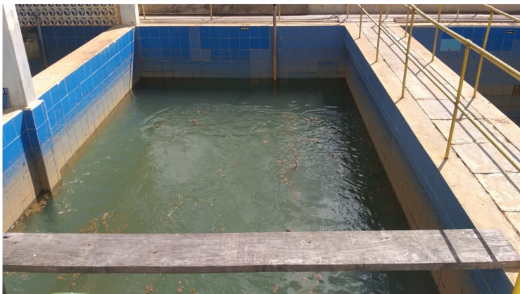
Figura 7: Tanques de filtração. Fonte: Os autores (2020).
