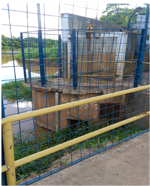
Figura 2: Bomba principal de captação de água. Fonte: Os autores (2020).
