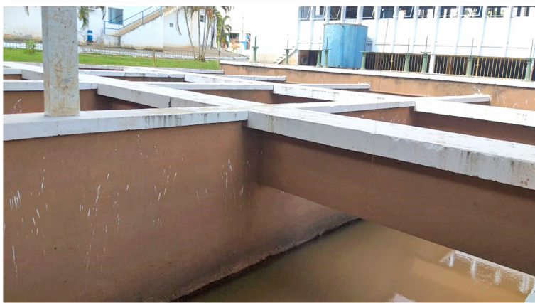
Figura 3: Tanques de areia. Fonte: Os autores (2020).
