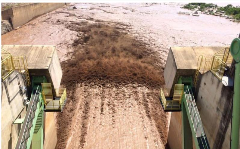
Figura 4: Vertedouro da Usina Baguari. Fonte: Aconteceu no Vale (2015).
